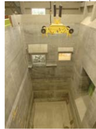
ごみピット ごみピットに溜められたごみを、ごみクレーンで攪拌した後、ごみ投入ホッパへ投入します。
